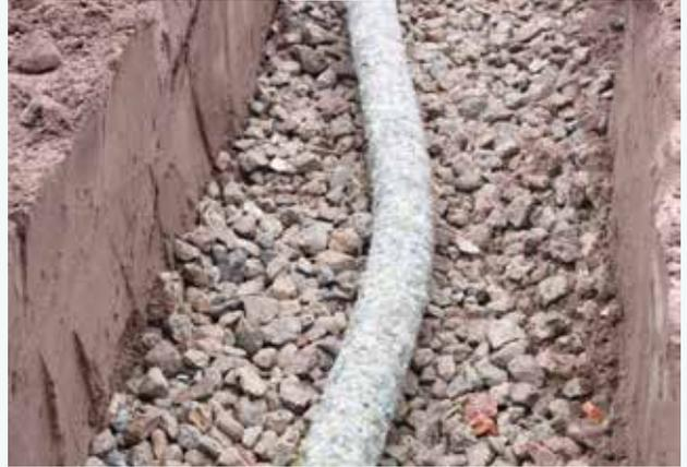
Remplissage de la tranchée avec du béton recyclé 10/40 et installation du tuyau de drainage.
