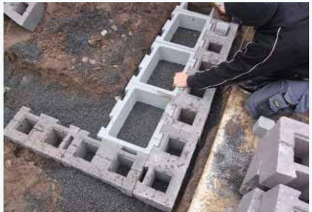
Pose du contre-bloc derrière le bloc G.
