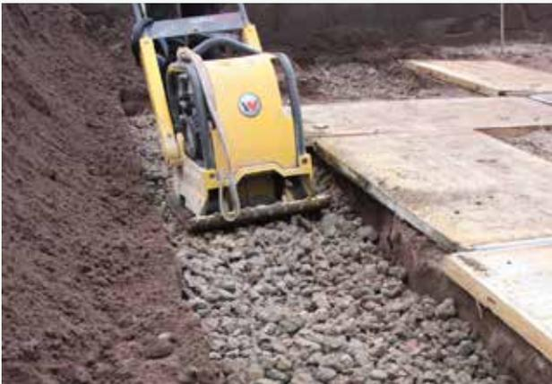
Remplissage avec du béton recyclé 10/40 et vibration.
