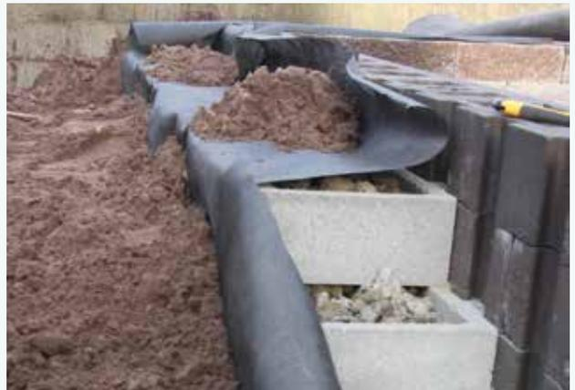
Pose de feutre géotextile sur la rangée supérieure de contre-blocs.
