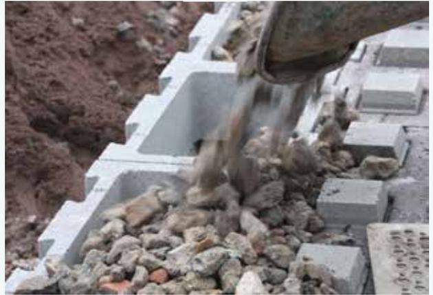
Remplissage du contre-bloc avec du béton recyclé 10/40 sans sable.
