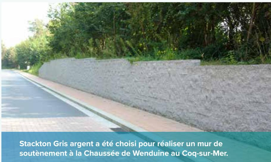
**Stackton Gris argent a été choisi pour réaliser un mur de soutènement à la Chaussée de Wenduine au Coq-sur-Mer.**
