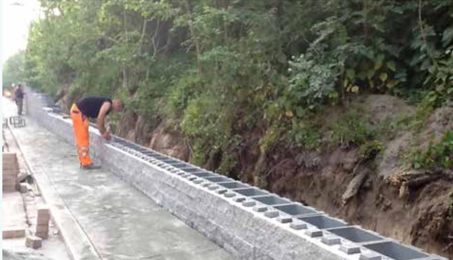
Stackton est un système de construction moderne qui offre de nombreuses possibilités d'application. Nous disposons d'une expérience et de compétences spécifiques pour vous assister dans la conception et la réalisation de constructions de soutènement armées.
