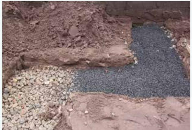
Pose de gravillons 2/4 ou de sable stabilisé avec 150 kg de ciment/m<sup>3</sup> et égalisation.
