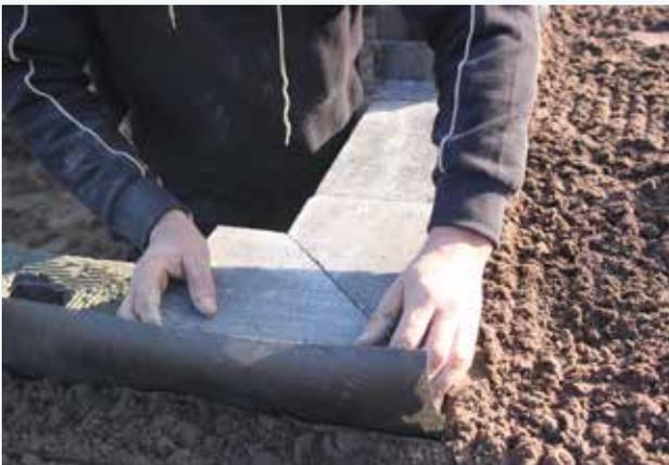
Pose du couvre-mur avec de la colle à béton (omnicol BB ou Murocol S, par exemple).
