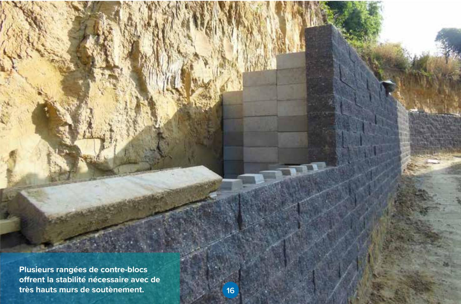
Plusieurs rangées de contre-blocs offrent la stabilité nécessaire avec de très hauts murs de soutènement.
