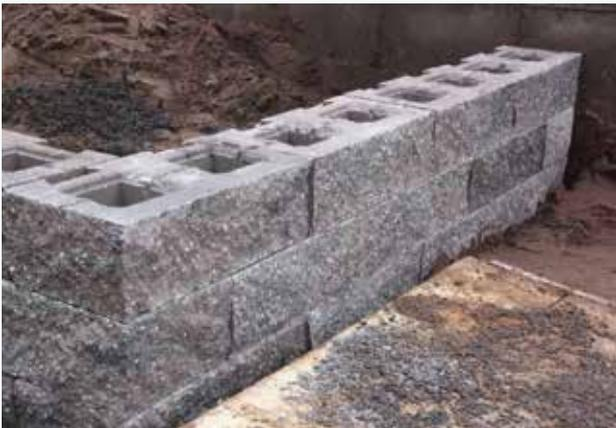
Pose des rangées suivantes de blocs G et de contre-blocs.
