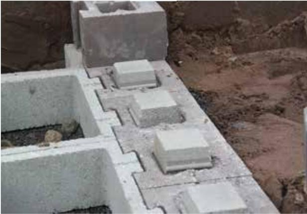
Pose des blocs d'ancrage.
